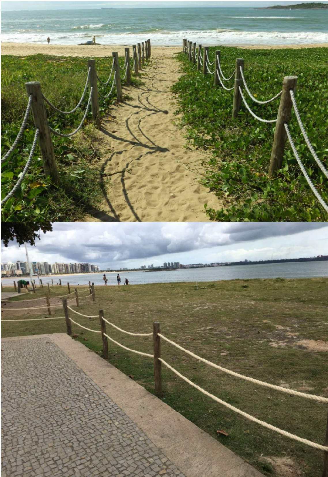
Figura 2: Cercamento com estacas de eucalipto e corda de sisal, implementada na Praia da Costa (cima) e na Praia de Camburi (baixo) para proteção da restinga. Fonte: Folha Vitória e Prefeitura de Vitória.
