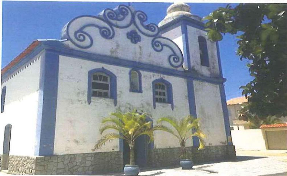
No Pilar da direita identifica-se Descolamento e Pulverulência (Desgaste de Reboco). A pintura apresenta sinais de Bolor/Crosta Negra/Fungos/Umidade. As Janelas em estrutura de madeira são originais.
