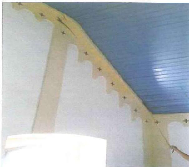
Vista do Forro Junto ao Teto: existe Desplacamento de Argamassa de Revestimento. O forro em frisos de madeira apresenta remendos em substituição ao forro original, possivelmente executados em substituição das peças que sofreram Ataque de Xilófagos. Recomendamos a substituição de todo o Forro do imóvel, por peças novas previamente imunizadas.
