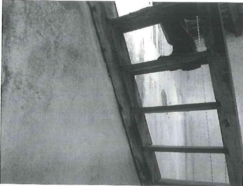
Foto da escada do Campanário por outro ângulo, a presença de umidade devido as aberturas superiores dos vãos propiciam a propagação de agentes decompositores de madeiras.
