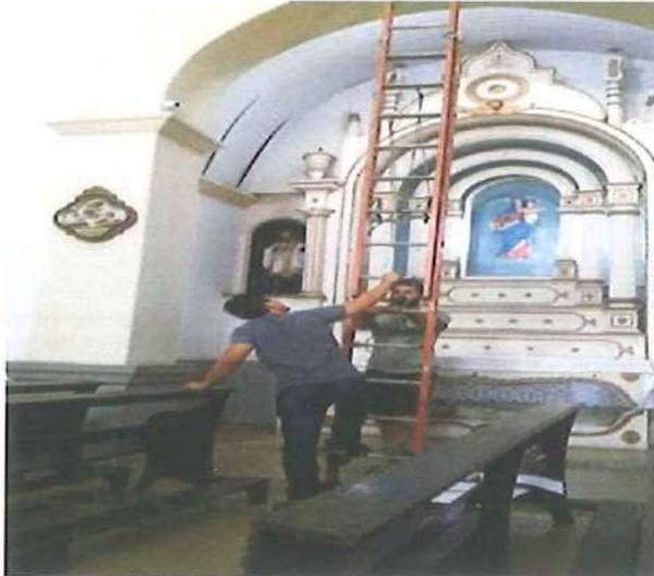
Vista do Retábulo Lateral: O Forro sofreu Prótese Incompatível. O forro original em frisos de madeira foi substituído por forro em frisos de PVC. Tal substituição alterou as características originais, tanto de material quanto na forma de assentamento em arco. Ver forma correta de assentamento na nave principal.
