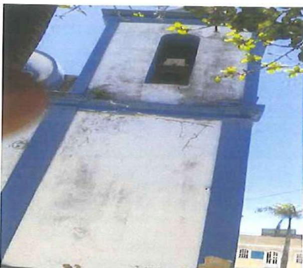
Na Torre do Campanário identifica-se no Pilar da direita Descolamento e Pulverulência (Desgaste de Reboco).
