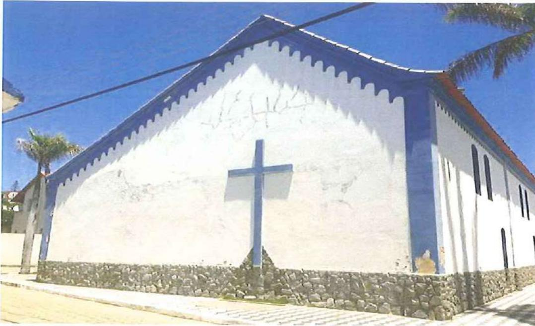
Nos Pilares da Direita e da Esquerda, identifica-se Descolamento e Pulverulência (Desgaste de Reboco).
