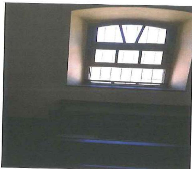
Modelo de Janela Original em Madeira: Sem exceção todas as janelas, do imóvel, apresentam descolamento na sua estrutura. Nas Ferragens Originais notam-se sinais de corrosão. Parte das Ferragens não Originais foram substituídas por outras não originais.
