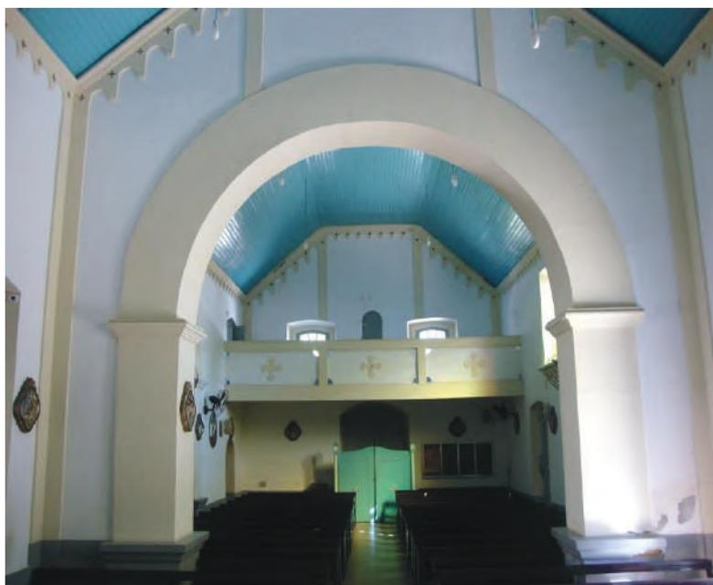
Arco-cruzeiro com vão central de 5,65 metros com pedestais na base, colunas retas com capitéis e arco central liso. Os pedestais são da mesma cor da faixa que circunda o perímetro interno da igreja. Não há elementos ornamentados no Arco-cruzeiro, a base do pedestal segue a faixa na cor cinza e o Arco no tom claro das molduras e frisos internos.
