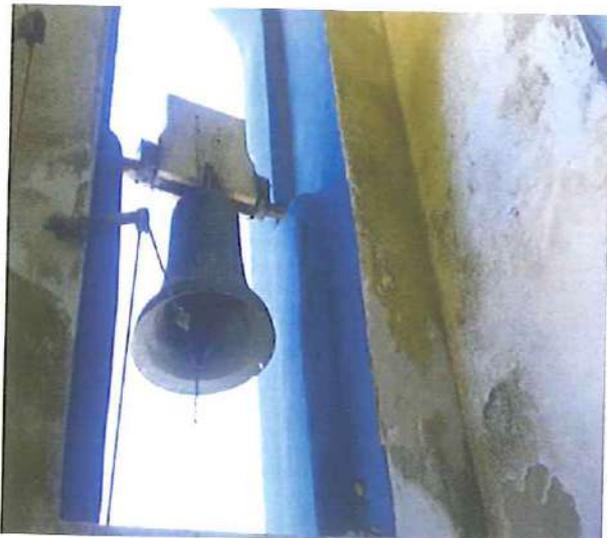
Na Vista Interna do Campanário observa-se a presença de corrosão no eixo metálico que sustenta o sino.
