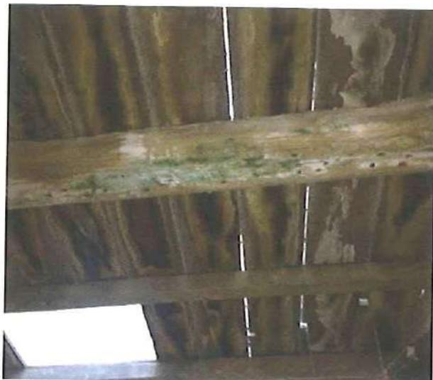
Vista Inferior do Piso do Campanário. Observa-se o Caibro Original, em primeiro plano e caibros substituindo os antigos originais. As tábuas do piso têm aparência de estar substituindo as originais. O piso apresenta sinais de Bolor/Crosta Negra/Fungos/Infiltração.
